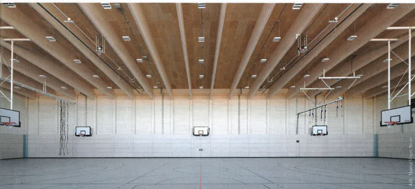
Holz zu Holz. Holzwolleplatten sorgen im gesamten Holzmodulbau für die nötige Schallabsorption, so wie hier in der Sporthalle.
