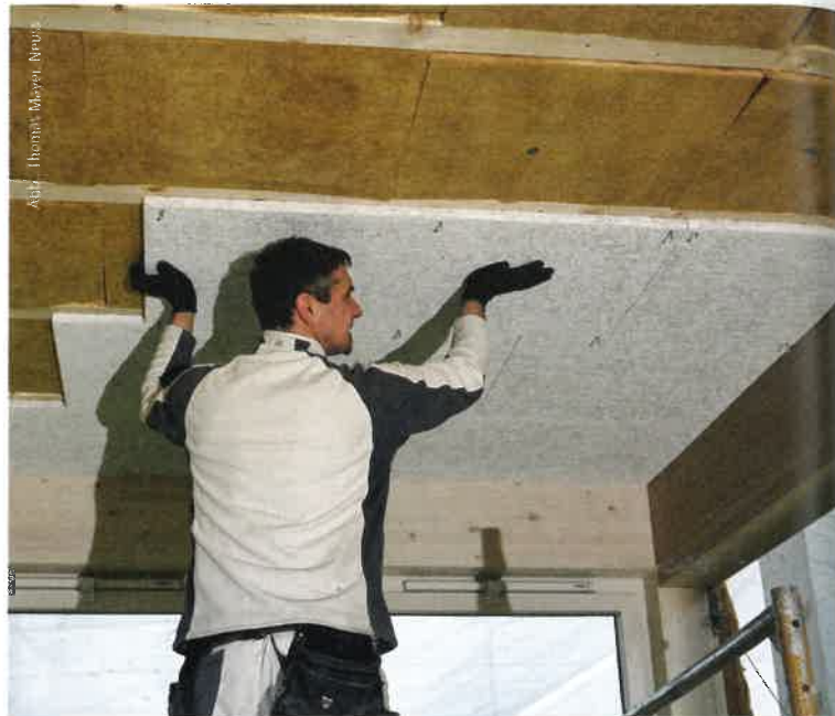
Beim Schulbau verwendet wurden mineralisch gebundene Holzwolleplatten (Fibro-Kustik Barcelona) aus superfeiner Holzwolle (1 mm).
