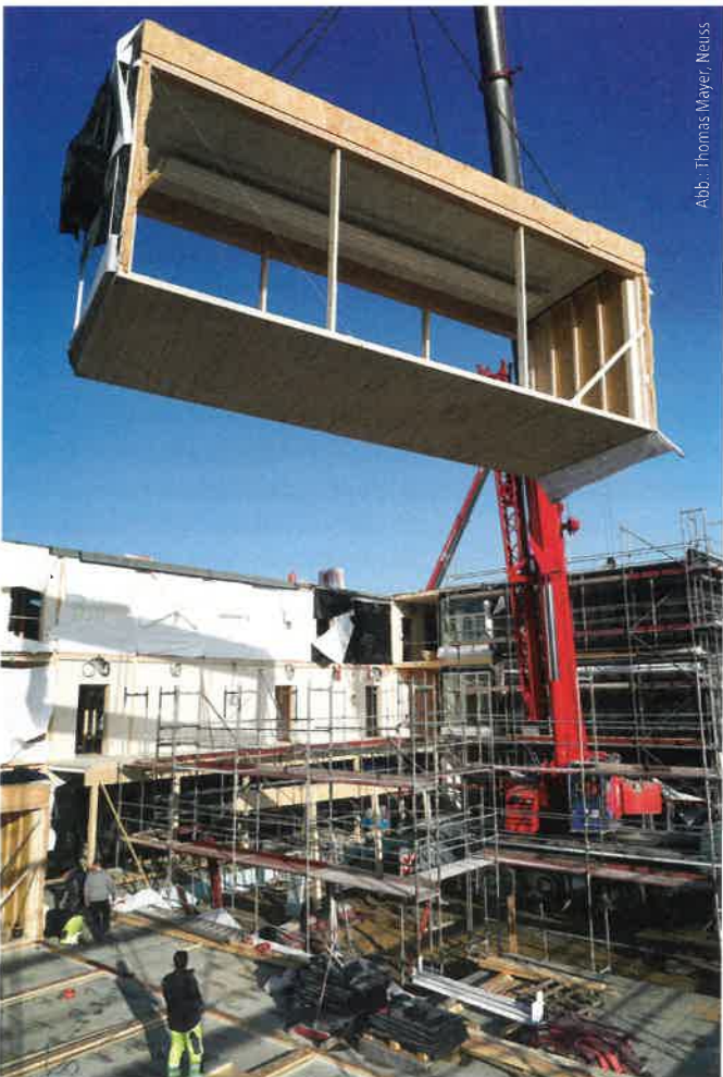
Serielle Vorfertigung, die Just-in-time-Anlieferung und die Montage auf der Baustelle hat das Bauvorhaben erheblich beschleunigt.
